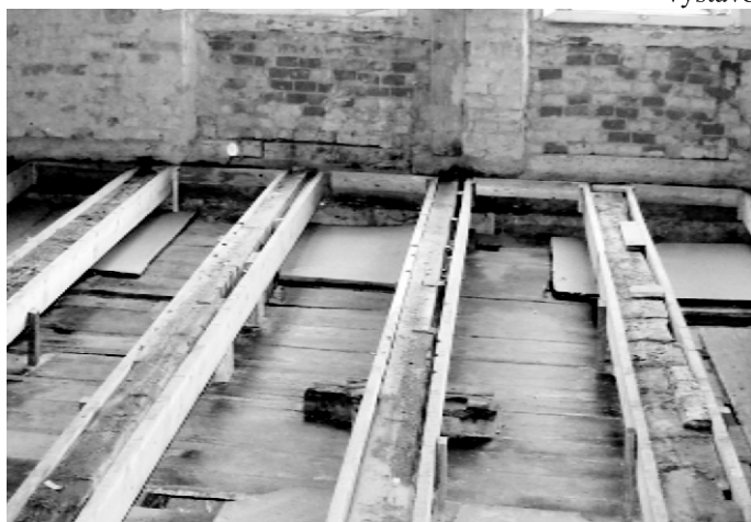
nová stropní konstrukce
